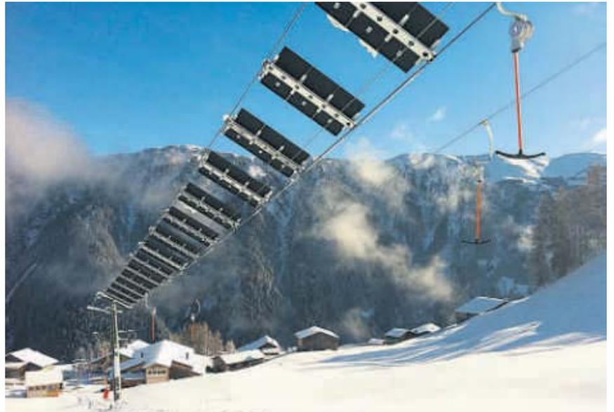
Der Skilift in Tenna mit den in acht Metern Höhe über der Schlepplift montierten sogenannten Solar-Wings. In dem Schweizer Solarpreis erhielt, hat die Photovoltaikanlage installiert.
