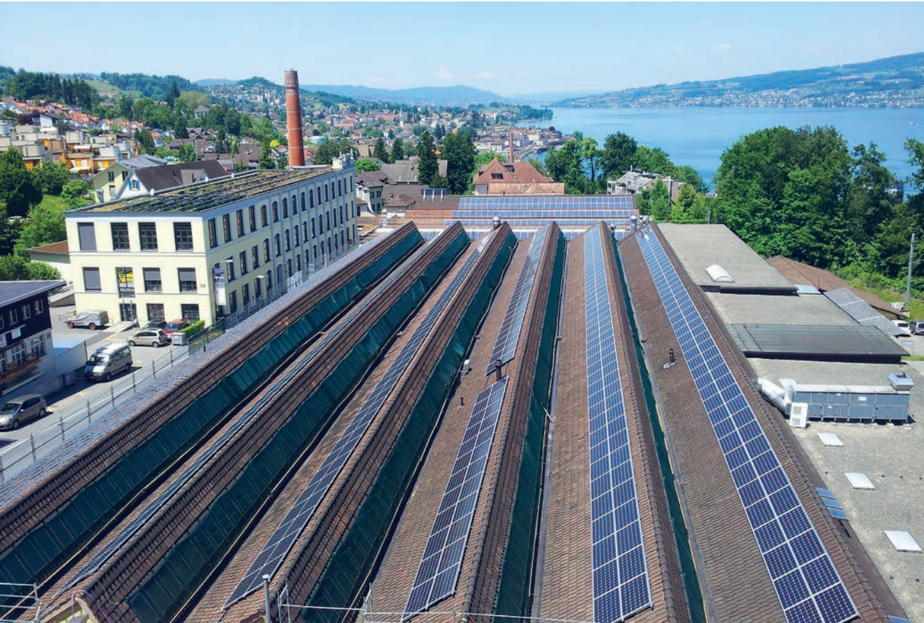
PV-Anlage auf den Dächern des Campus Reidbach.
