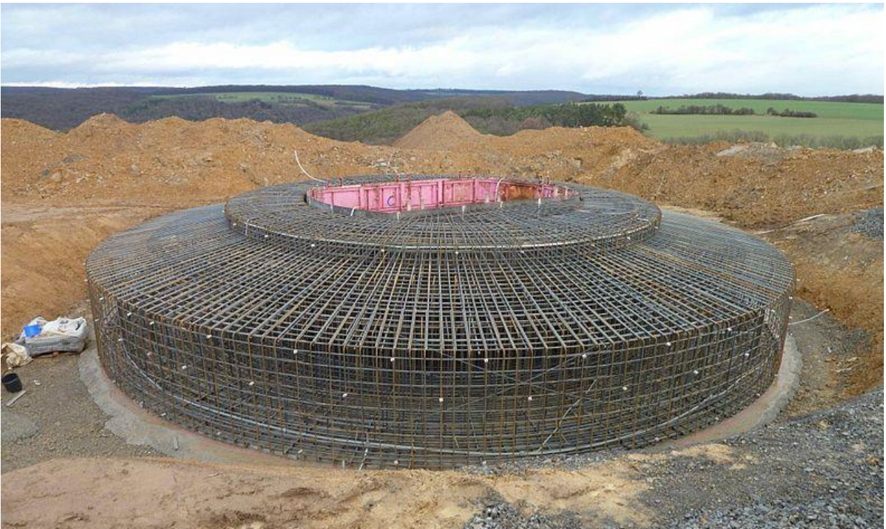
Abbildung 2-3: Bewehrung eines Fundaments für eine Windkraftanlage in Schonungen (Deutschland). Bild: Wikipedia Commons
