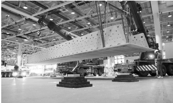
Einheben der Brücke an der Swissbau
