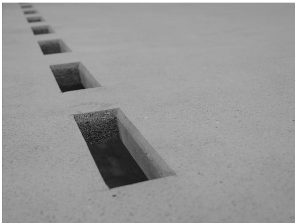
Ausfräsungen der Verbindung in der CPC Brückenplatte
