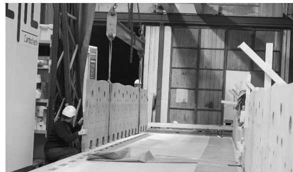
Setzen der Brüstungselemente
