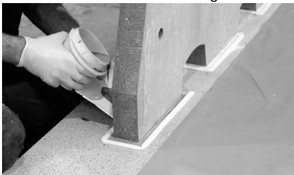
Vermörteln der Verbindung
