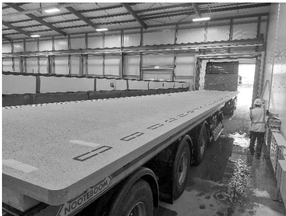
Transport der 17m langen und 3m breiten und 7 cm starken CPC-Platten in die Schweiz
