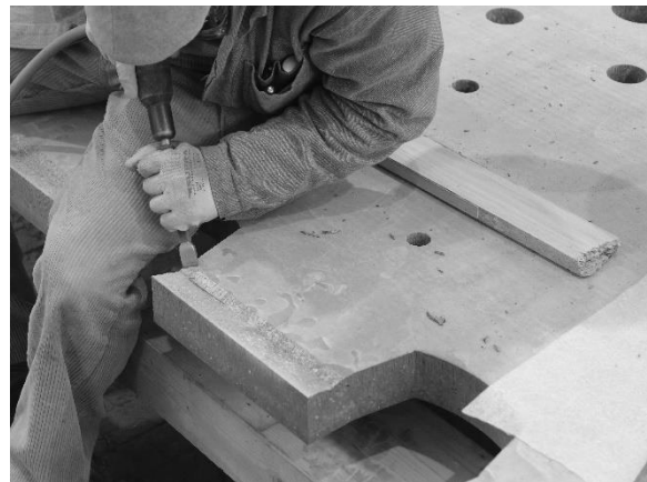
Erstellung der Keilverbindung am der Brüstung
