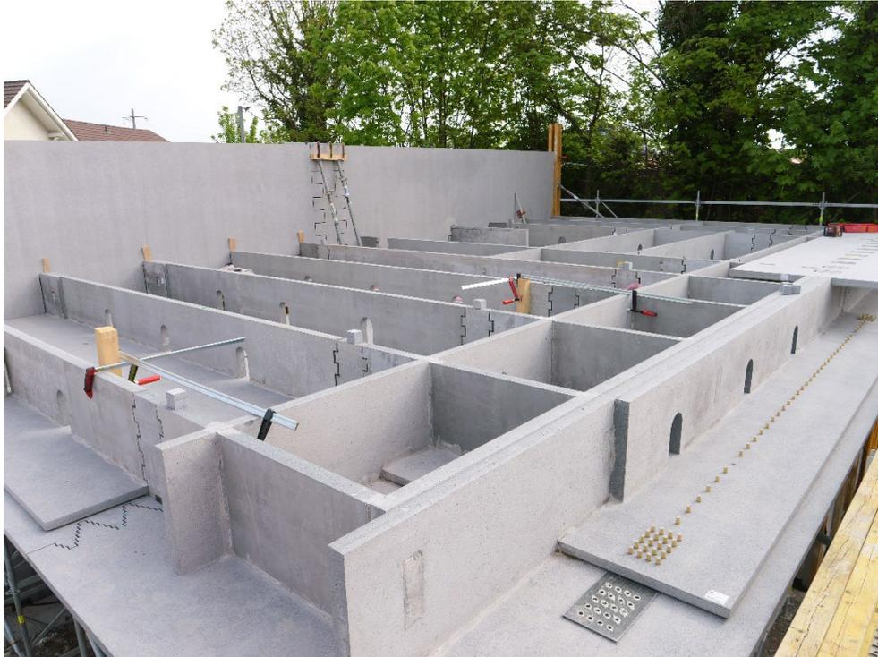
Durch die zum Patent angemeldete Zip-Verzahnung können Zugkräfte effizient übertragen werden. Dies ermöglicht es, Elemente unterschiedlicher Grösse nahtlos miteinander zu verbinden und Endlosdecken mit beliebigen Formen zu schaffen. Erhält die Zip-Verzahnung Zugkräfte, so bilden sich in der vermörtelten Verbindung Druckdiagonalen aus und die Zugkräfte können von Platte zu Platte übertragen werden.
