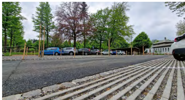
Abb. 1: Sickerfähiger Belag und neue Baumrabbatte versickern das Regenwasser nach dem Schwammstadtprinzip (Foto: ZHAW).
