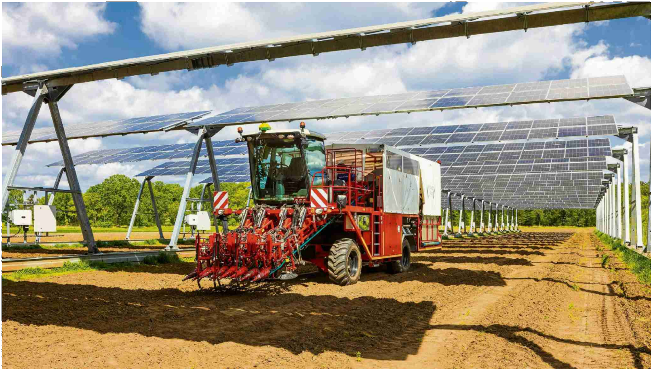
Agrofotovoltaikanlage in Norddeutschland: In mehreren Metern Höhe installierte Solarmodule lassen Platz für die maschinelle Bearbeitung des Ackerbodens. Foto: Agrosolar Europe
