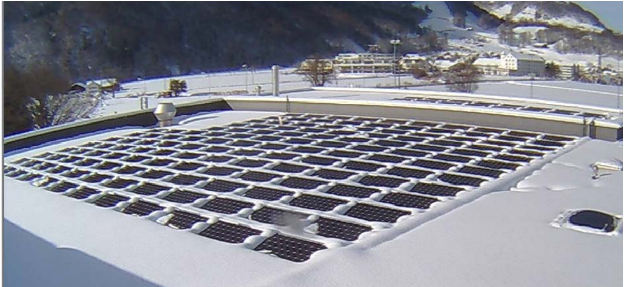
Abbildung 13: PVT-Module auf der linth-arena sgu am 17.01.2016: Schnee zwischen den Modulen führt zu Verschattungen.
