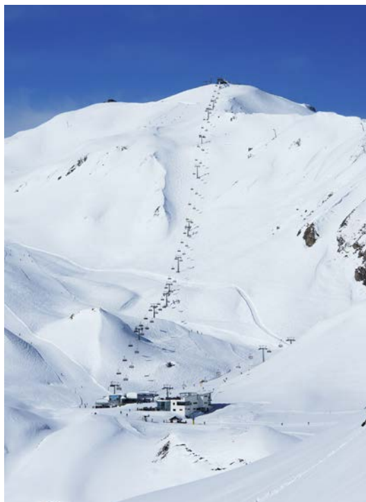
Skilift-Anlage im Skigebiet Samnaun/Ischgl.
